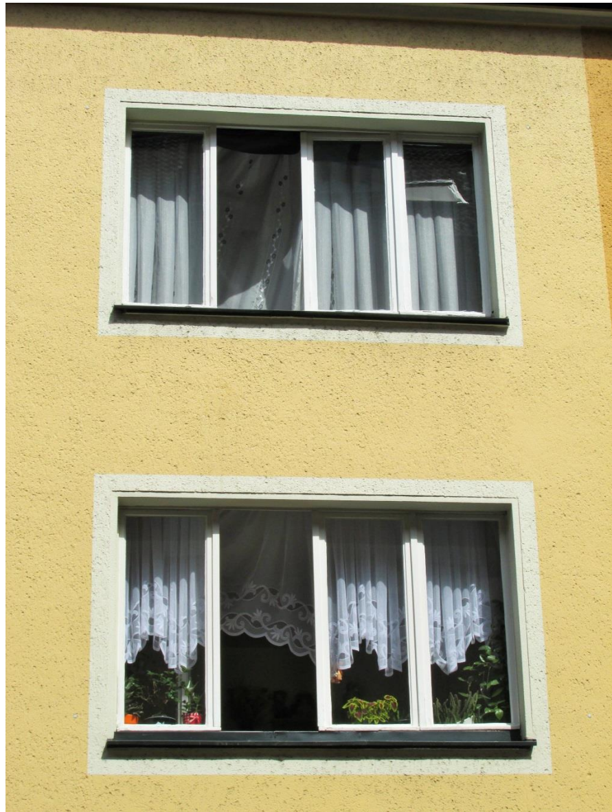
Positives Beispiel für eine Fassadengliederung mit zeittypischer Fenstergliederung (Fensterband aus den 1960er Jahren); allerdings entsprechen die alten Fenster nicht mehr dem heutigen energetischen Standard
