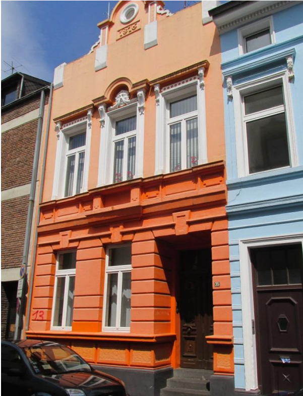
Negatives Beispiel: Hervorstechende Farbigkeit und fehlende optische Hervorhebung der Fassadenornamente im Erdgeschossbereich
