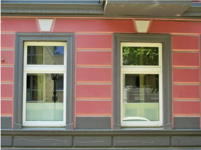
Negatives Beispiel: Gründerzeitfassade mit nicht auf die Fassade abgestimmter Fensterteilung (besser: Teilung des unteren Öffnungsflügels in zwei Öffnungsflügel)
