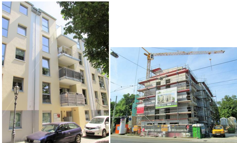
Fertiggestellter Neubau in der Corneliusstr. (links) und Rohbau an der St.-Anton-/Steinstr.
