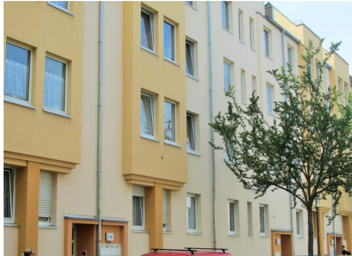
Positives Beispiel: Zurückhaltende Farbigkeit der Fassade; aufeinander abgestimmte Farben; farbliche Untergliederung der Fassade durch kräftigeren Farbton für die Erkerzimmer und den Hauseingangsbereich
