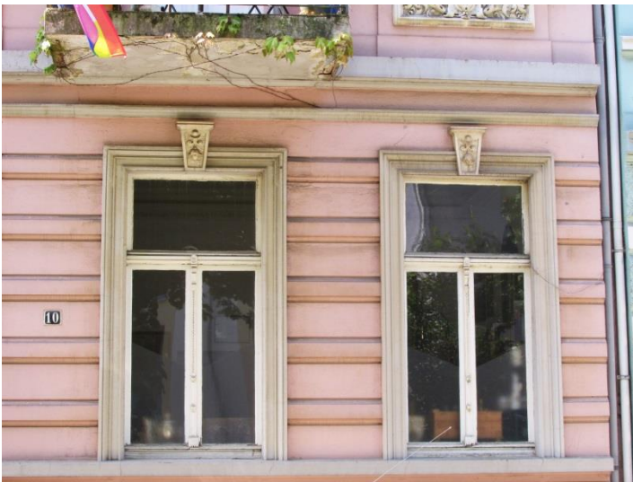
Positives Beispiel: Gründerzeitfassade mit auf die Fassade abgestimmter Fensterteilung (mit zweiflügeligem Öffnungsflügel, Kämpfer; Oberlicht allerdings nicht unterteilt)
