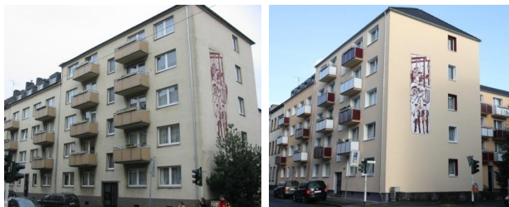
„Vorher und Nachher“ einer gedämmten Fassade
