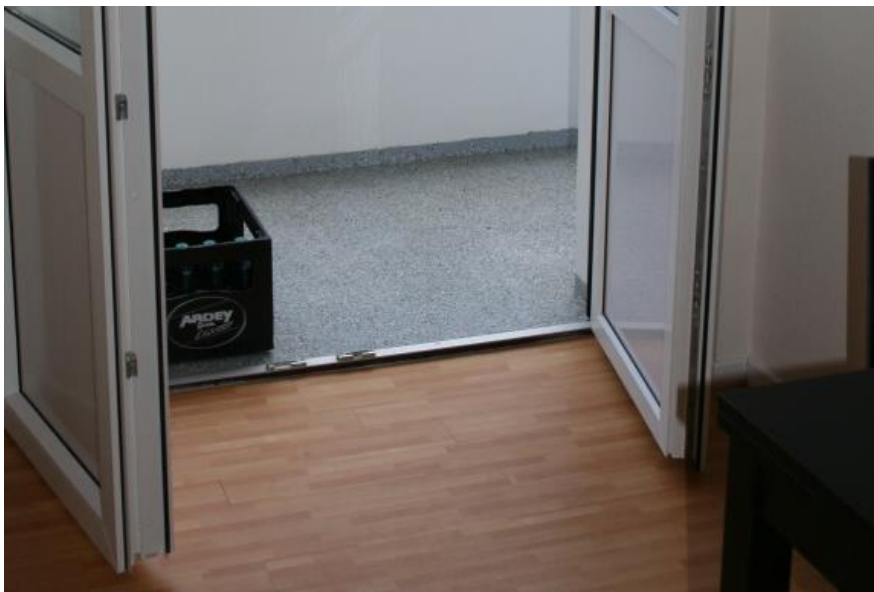
Beispiel für einen schwellenlosen Übertritt zum Balkon
