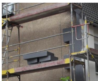
Anbringung einer Außenwanddämmung
