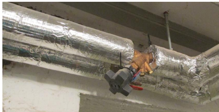
Dämmung von Warmwasserrohren in ungeheizten Räumen
