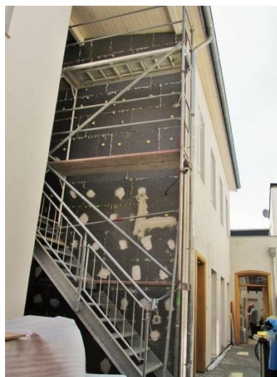
Dämmung des Seitenflügels eines Krefelder Hauses
