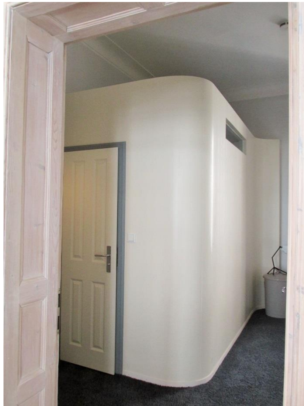
Positives Beispiel: großzügiges Appartement mit einem designten, in das Schlafzimmer integrierten Badezimmer; Lichtschlitz für natürliche Belichtung; automatische Entlüftung
