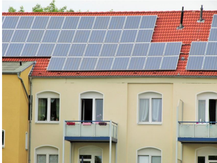
Hausdach mit Solarkollektoren
