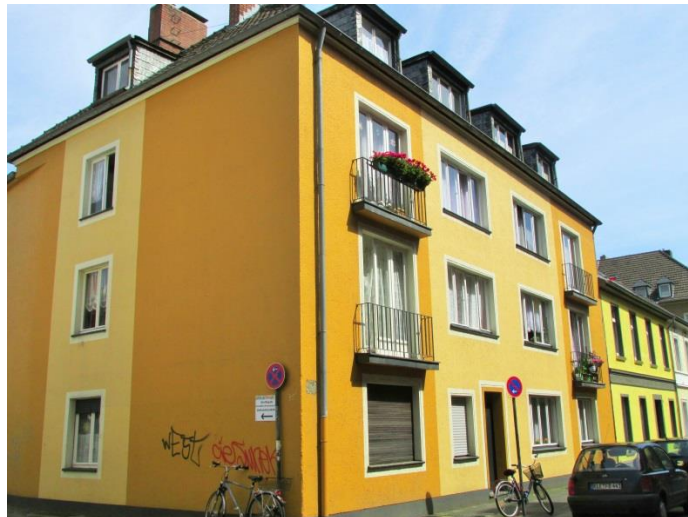
Positives Beispiel: Untergliederung der Fassade durch Farbbänder und optischer Hervorhebung von Fenster- und Türlaibung; aufeinander abgestimmte Farben; allerdings tw. kräftige Farbgebung
