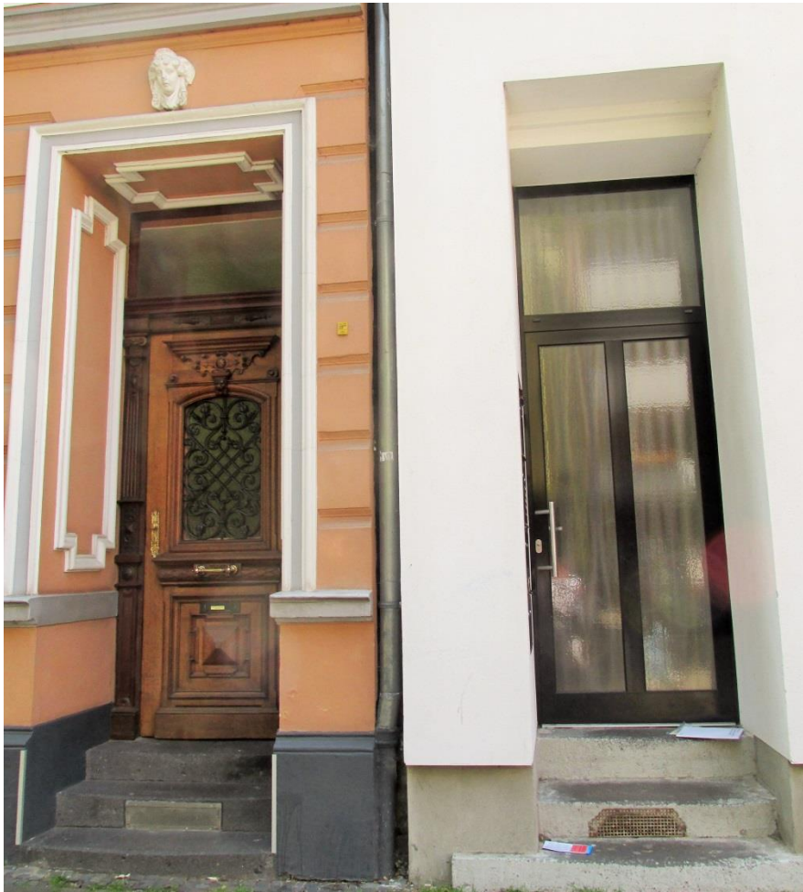
Negatives Beispiel beim rechten Haus: der vorhandene Bauzier ist aufgrund der Wärmedämmung der Außenfassade vollständig verdeckt; Neue Haustür setzt energetische Modernisierung zwar konsequent um; Individualität und Altbaucharme gingen jedoch gänzlich verloren
