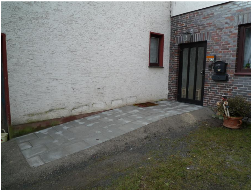
Nachträgliche barrierefreie Erschließung eines Wohngebäudes über Anschüttung und Anbringung einer Rampe in einer Innenhofsituation
