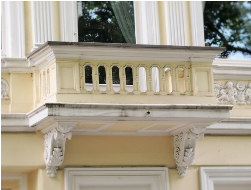
Positives Beispiel: in die Fassadengestaltung farblich integrierter, sanierter Zierbalkon; Gebrauchswert aufgrund seiner Größe gegeben
