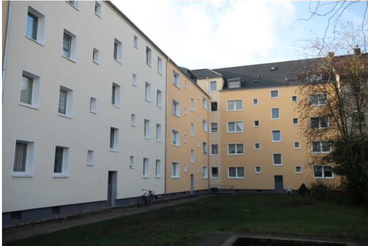
Nachkriegsbebauung der 1950er Jahre (bereits modernisiert)
