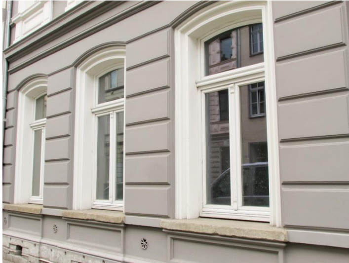
Positives Beispiel: Gründerzeitfassade mit auf die Fassade abgestimmter Fensterteilung (mit zweiflügeligem Öffnungsflügel sowie Anpassung am gebogenen Sturz; Oberlicht allerdings nicht unterteilt)
