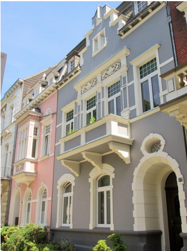
Positives Beispiel: zurückhaltende Farbigkeit; Hervorhebung des Sockelbereiches und aller Fassadenornamente; farbliche Betonung der Fenster- und Türumgebungen
