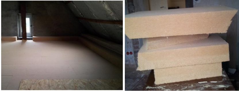
Dämmung der obersten Geschossdecke mit trittfesten Dämmplatten
