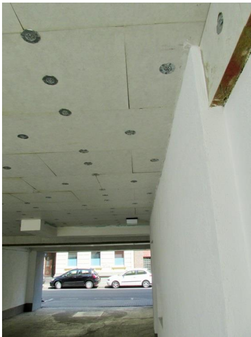
Dämmung der Decke in der Durchfahrt zum Hinterhof
