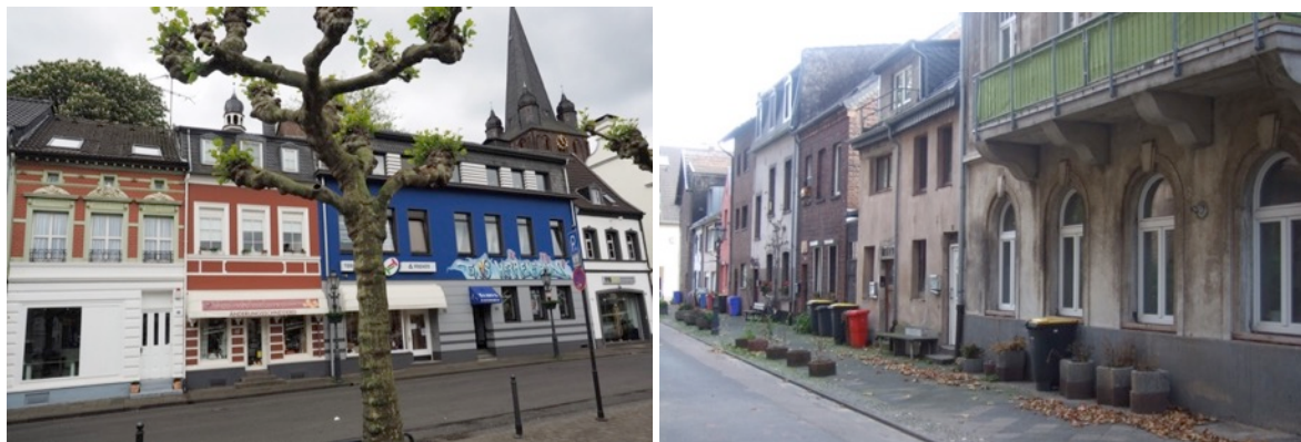
Foto 57 und Foto 58: Beispiel Werbeanlagen (links), Fassaden (rechts)
