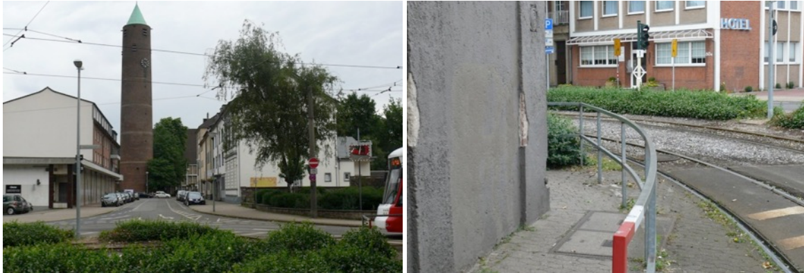
Foto 35 und Foto 36: Am Bahnhofplatz in Richtung Niederstraße (links) Bürgersteig Kreuzung Kurfürstenstraße/ Am Bahnhofplatz
