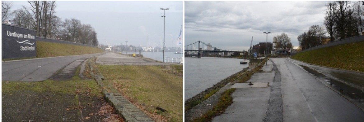
Foto 19 und Foto 20: Unteres Werft, Blick nach Norden (links), Blick nach Süden (rechts)
