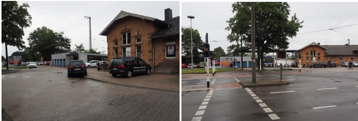
Foto 33 und Foto 34: Vorplatz Bahnhof Krefeld-Uerdingen
