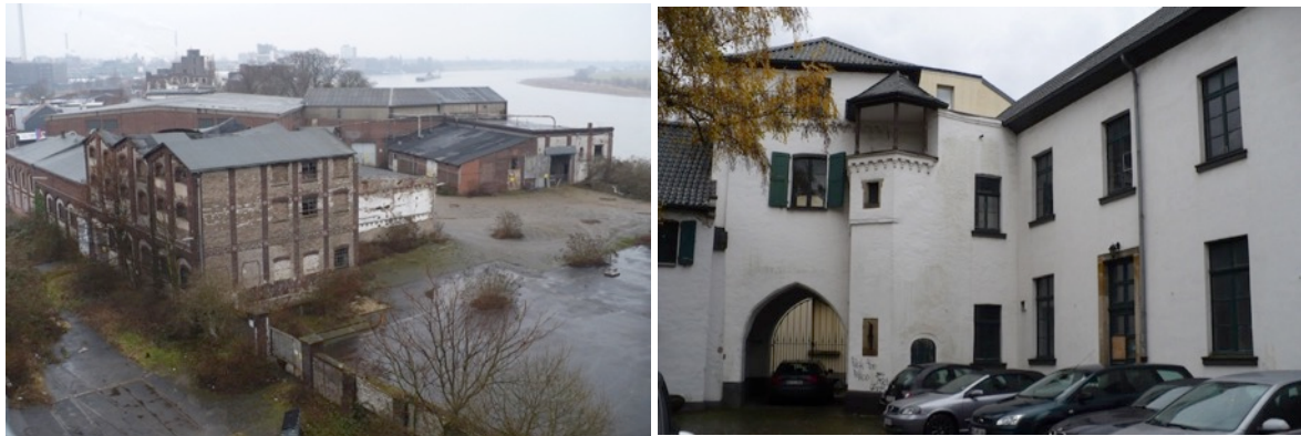
Foto 61 und Foto 62: Brachliegende Fläche nördlich des Unteren Werft (links), Brempter Hof (rechts)
