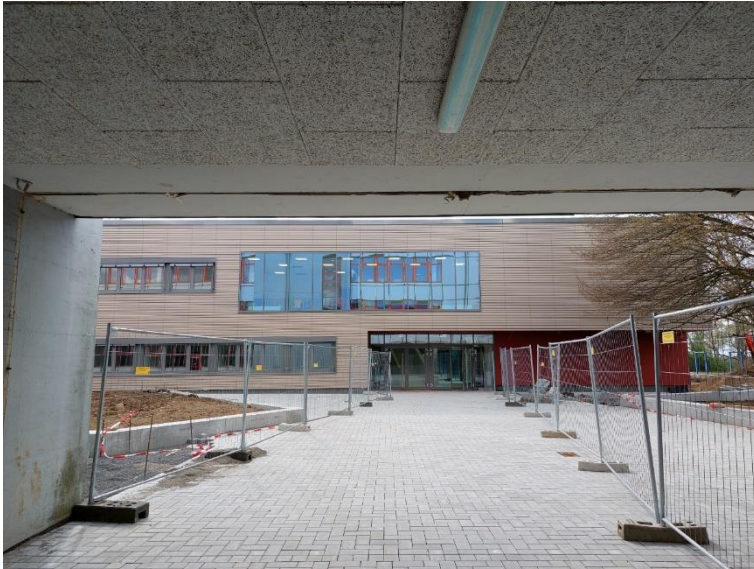
Abbildung 25 - Gesamtschule Robert Jungk. Fassade Neubau
