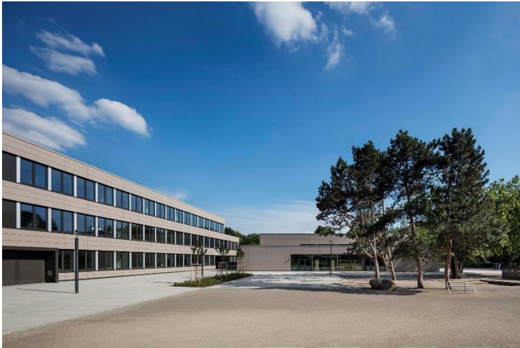
Abbildung 26 - Ges Uerdingen. Fassade An- und Neubau (Quelle: Hahn Helten Generalplaner GmbH)
