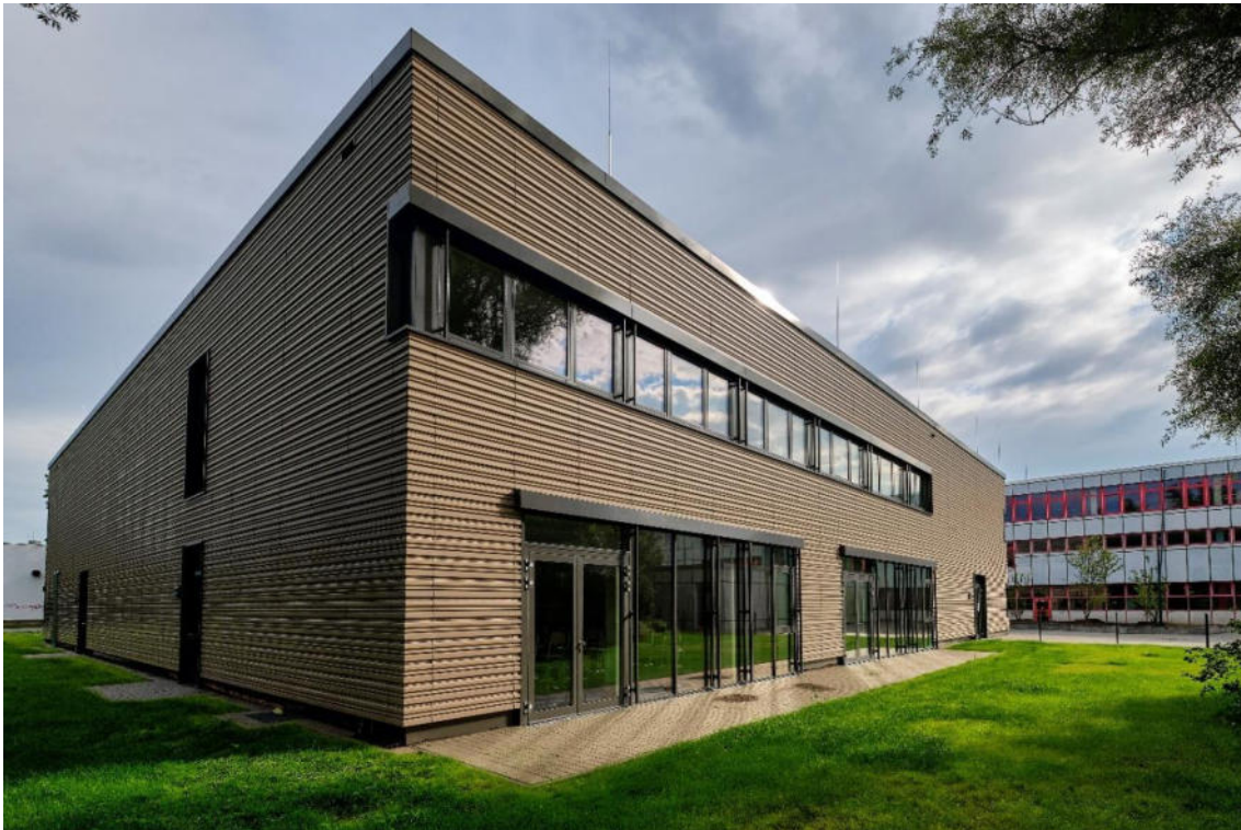
Abbildung 44 – Robert-Jungk-Gesamtschule - Ansicht Neubau ©Tonality
