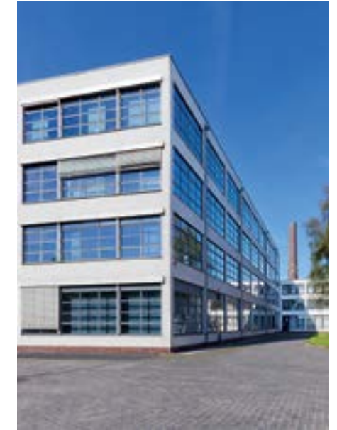
Mies van der Rohe Business-Park.
