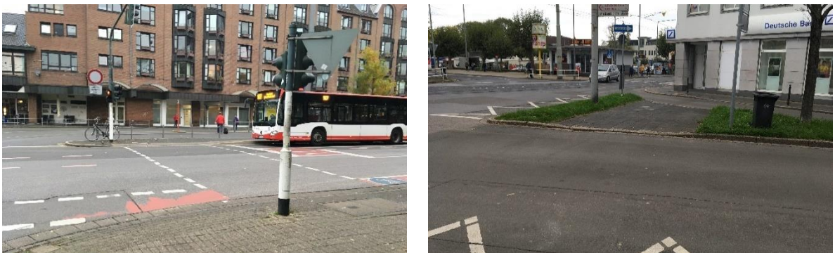
Abbildung 5: Fehlende barrierefreie Ausstattung von Querungsanlagen in Krefeld (links) und in Uerdingen (rechts)
