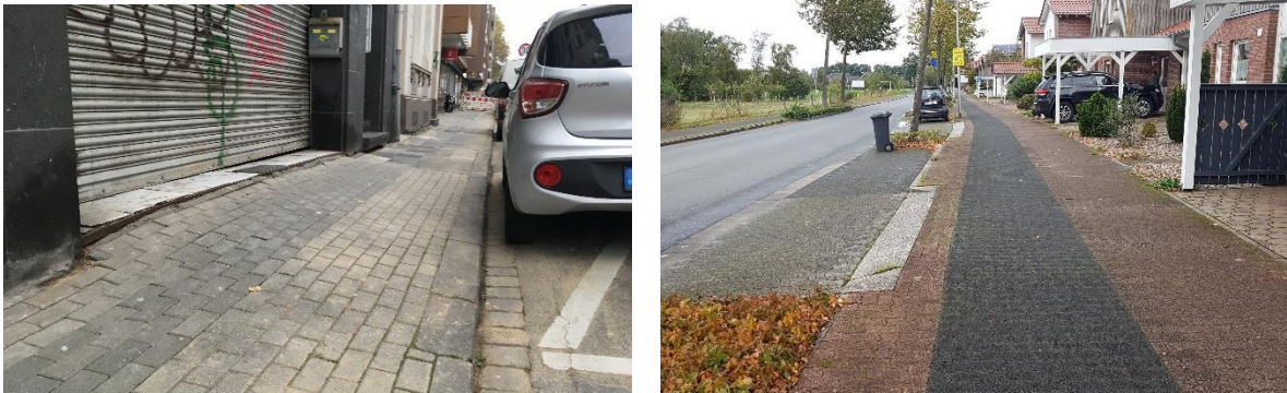
Abbildung 9: Hohe Querneigung Petersstraße (links) Absenkung mit Schrägbord (rechts)
