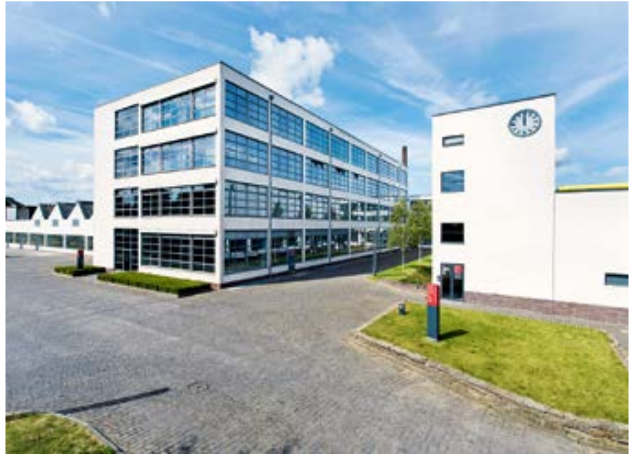
HE-Gebäude, Mies van der Rohe Business Park. Foto © Mies van der Rohe Business Park
