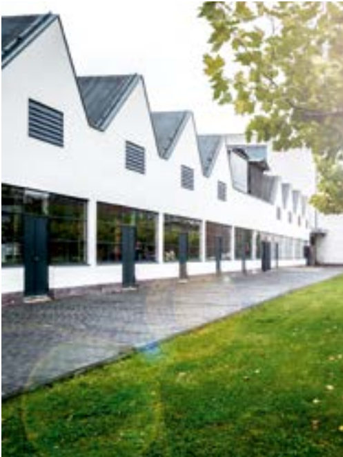
Sheddach im Mies van der Rohe Business Park. Foto © Heiner Engbrocks
