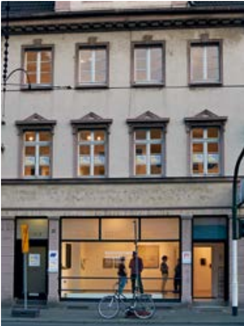
Aussenansicht der GKK e.V., Krefeld. Foto © Wolfram Schmidt, Regensburg
