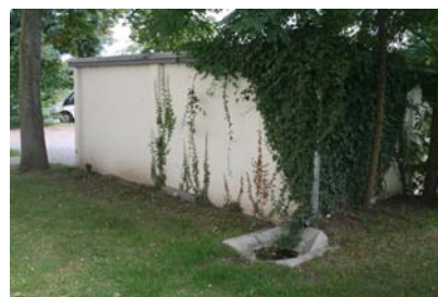
Offene Ableitung von Regenwasser
